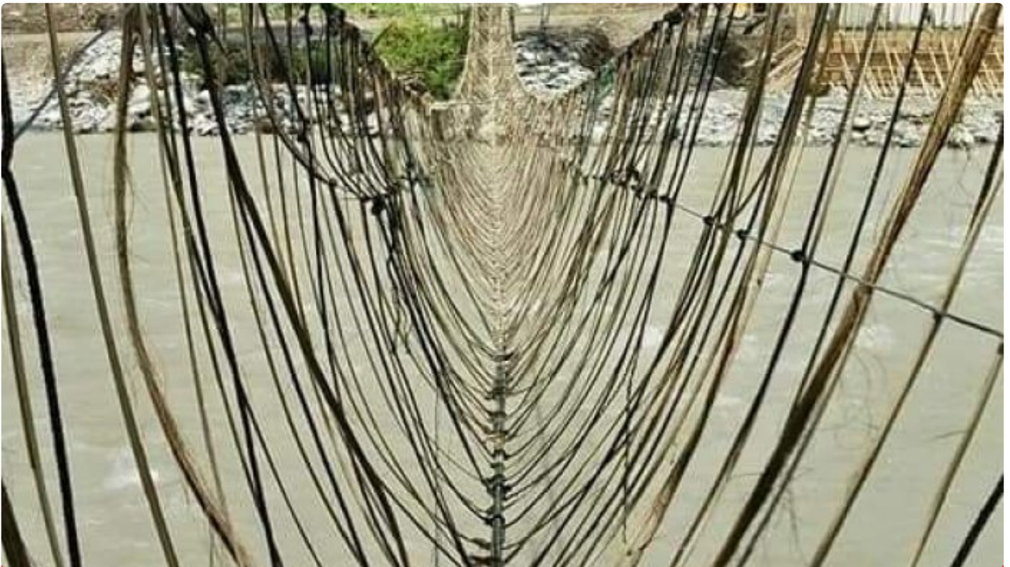
Jembatan sungai Digoel, sebelum kejadian.
